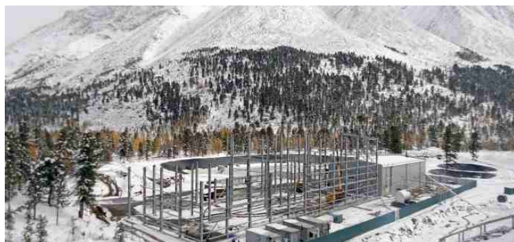
Монтаж производственного корпуса
